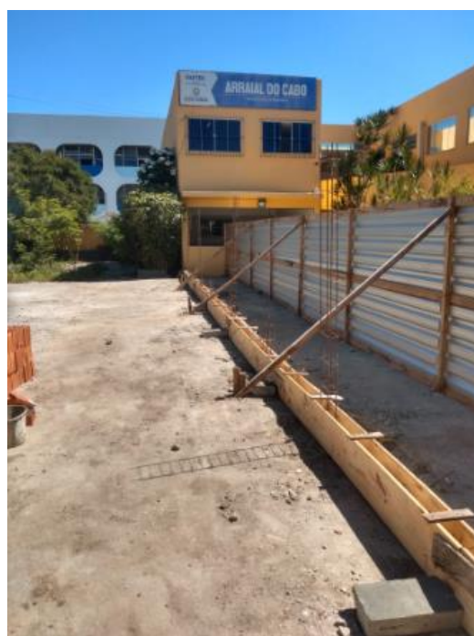
Execução de forma e armações da viga de fundação
