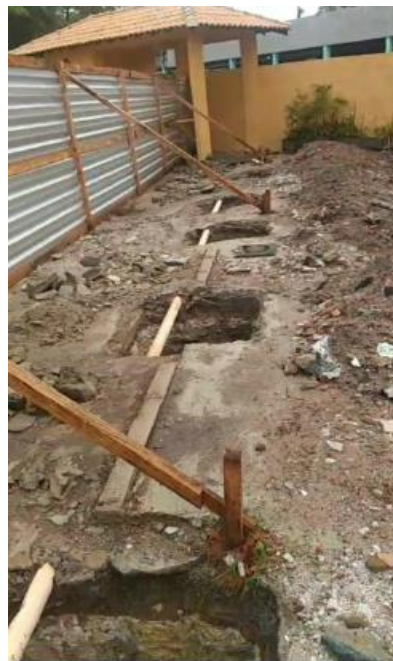
Escavações de 11 sapatas no perímetro construção do muro de divisa
