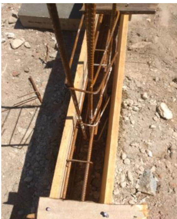
Execução de forma e armações da viga de fundação
