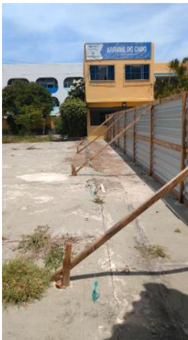
Retirada canteiro existente e demarcações Gabarito escavação
